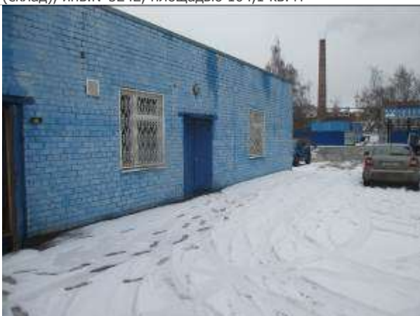
Фото 21. Здание материально-технического снабжения (склад), инв.№5242, площадью 104,1 кв. м
