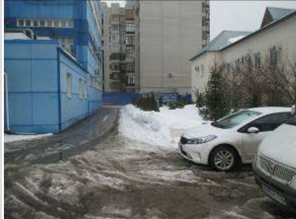
Фото 30. Здание материально-технического снабжения (склад), инв.№5242, площадью 104,1 кв. м
