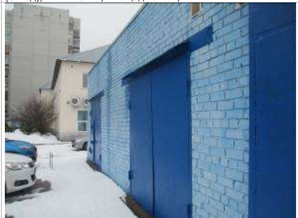
Фото 28. Здание материально-технического снабжения (склад), инв.№5242, площадью 104,1 кв. м
