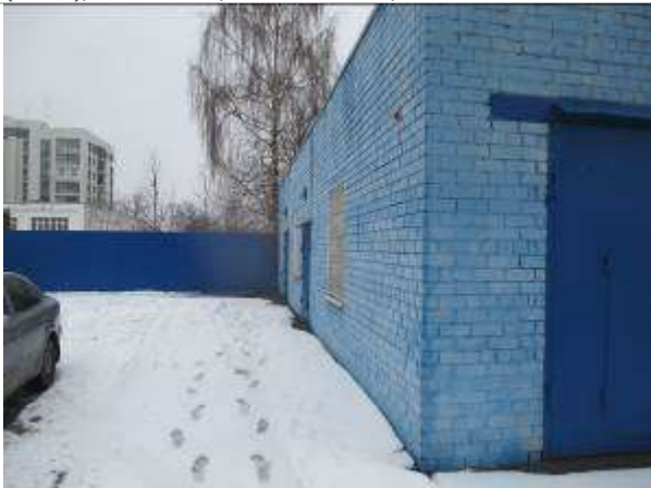
Фото 25. Здание материально-технического снабжения (склад), инв.№5242, площадью 104,1 кв. м
