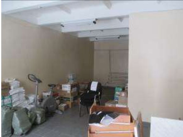
Фото 5. Здание материально-технического снабжения (склад), инв.№5242, площадью 104,1 кв. м
