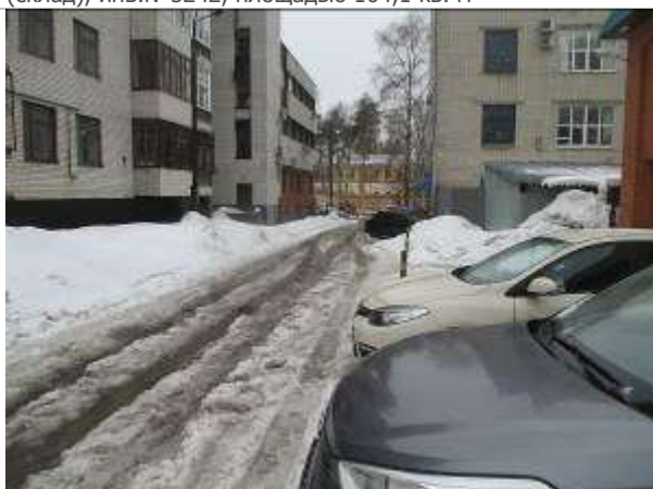
Фото 37. Здание материально-технического снабжения (склад), инв.№5242, площадью 104,1 кв. м
