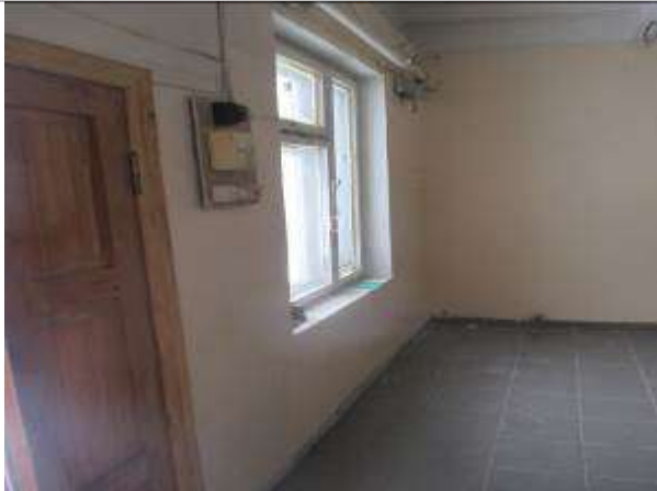
Фото 7. Здание материально-технического снабжения (склад), инв.№5242, площадью 104,1 кв. м
