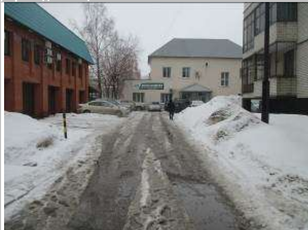
Фото 36. Здание материально-технического снабжения (склад), инв.№5242, площадью 104,1 кв. м
