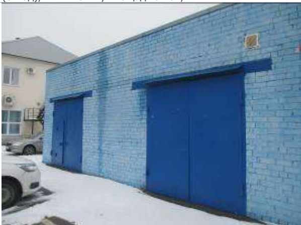
Фото 27. Здание материально-технического снабжения (склад), инв.№5242, площадью 104,1 кв. м
