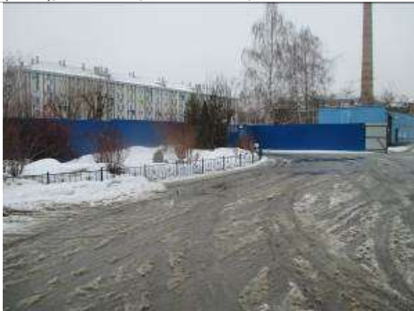
Фото 31. Здание материально-технического снабжения (склад), инв.№5242, площадью 104,1 кв. м
