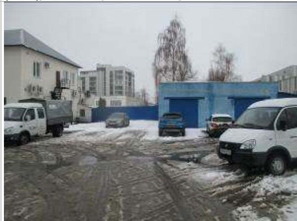
Фото 32. Здание материально-технического снабжения (склад), инв.№5242, площадью 104,1 кв. м
