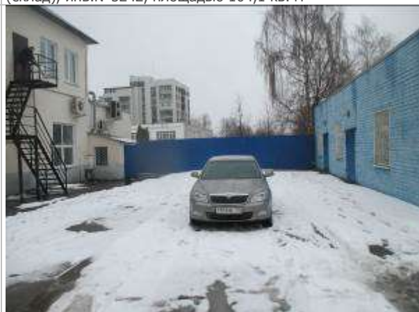
Фото 34. Здание материально-технического снабжения (склад), инв.№5242, площадью 104,1 кв. м
