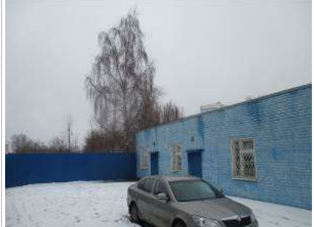
Фото 24. Здание материально-технического снабжения (склад), инв.№5242, площадью 104,1 кв. м
