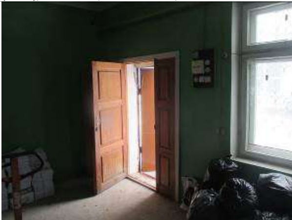
Фото 19. Здание материально-технического снабжения (склад), инв.№5242, площадью 104,1 кв. м
