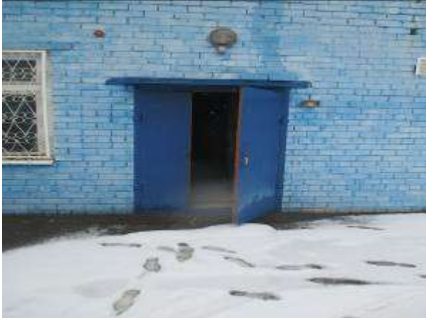
Фото 17. Здание материально-технического снабжения (склад), инв.№5242, площадью 104,1 кв. м
