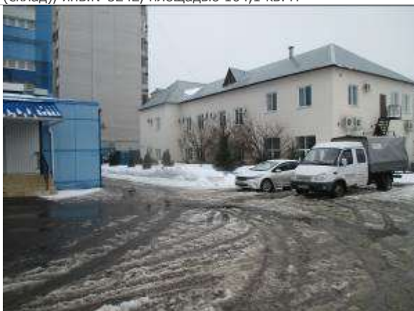
Фото 33. Здание материально-технического снабжения (склад), инв.№5242, площадью 104,1 кв. м
