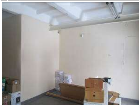
Фото 2. Здание материально-технического снабжения (склад), инв.№5242, площадью 104,1 кв. м
