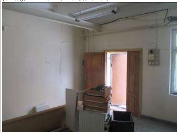
Фото 4. Здание материально-технического снабжения (склад), инв.№5242, площадью 104,1 кв. м
