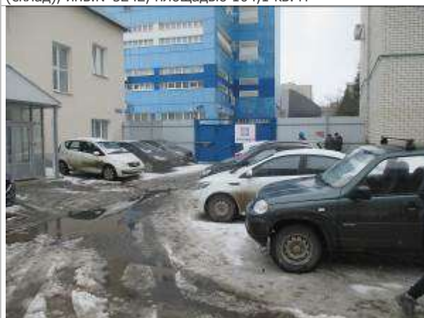
Фото 38. Здание материально-технического снабжения (склад), инв.№5242, площадью 104,1 кв. м
