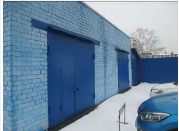
Фото 26. Здание материально-технического снабжения (склад), инв.№5242, площадью 104,1 кв. м
