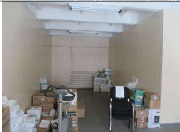
Фото 1. Здание материально-технического снабжения (склад), инв.№5242, площадью 104,1 кв. м
