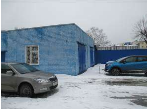
Фото 23. Здание материально-технического снабжения (склад), инв.№5242, площадью 104,1 кв. м
