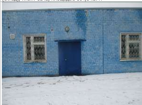
Фото 22. Здание материально-технического снабжения (склад), инв.№5242, площадью 104,1 кв. м
