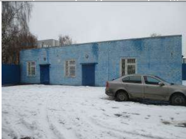
Фото 35. Здание материально-технического снабжения (склад), инв.№5242, площадью 104,1 кв. м
