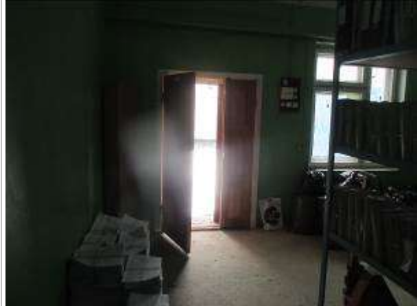
Фото 18. Здание материально-технического снабжения (склад), инв.№5242, площадью 104,1 кв. м
