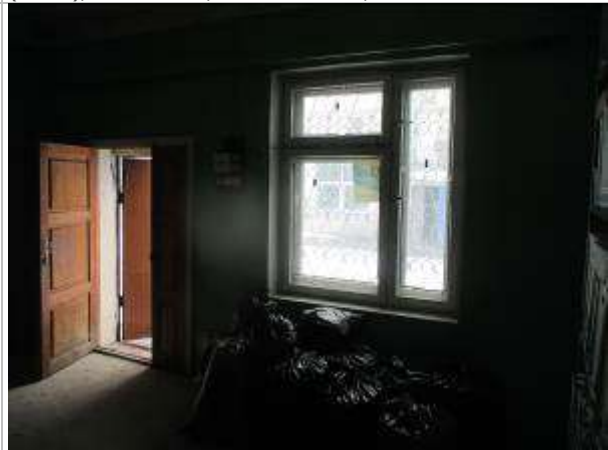
Фото 20. Здание материально-технического снабжения (склад), инв.№5242, площадью 104,1 кв. м
