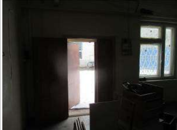
Фото 6. Здание материально-технического снабжения (склад), инв.№5242, площадью 104,1 кв. м
