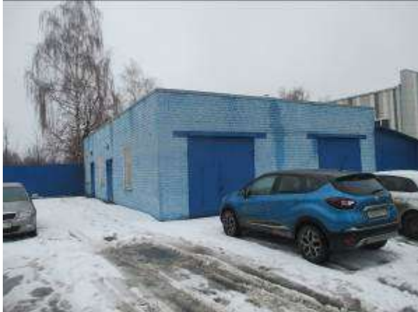
Фото 29. Здание материально-технического снабжения (склад), инв.№5242, площадью 104,1 кв. м
