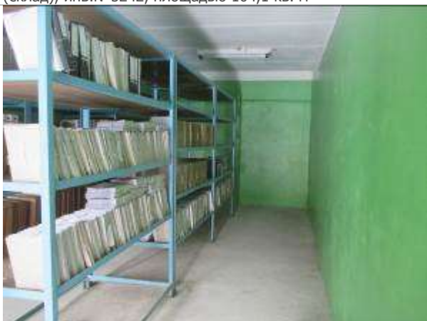
Фото 9. Здание материально-технического снабжения (склад), инв.№5242, площадью 104,1 кв. м
